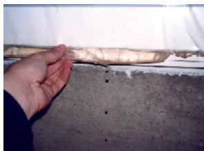
Bild 4: Tauwasseransammlung an mit Folie abgedecktem Fenster (Foto: Fa. Hans Timm, Berlin)
