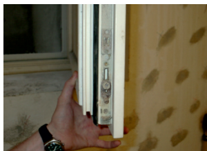
Bild 3: Weißkorrosion an Beschlagteilen (Foto: Fa. Heinrich Menck, Hamburg)
